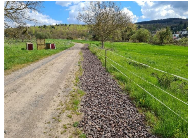
Straßenbegleitende Rigolen in Oberbieber, Quelle: BCE
